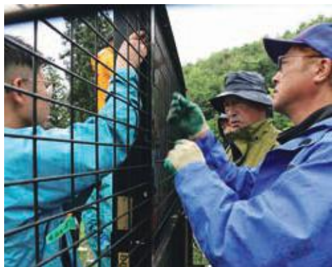
雨の中、設置が進んだ大型檻
